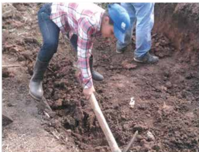
Imagen Nº 2: Zanja para Infiltración de agua.
